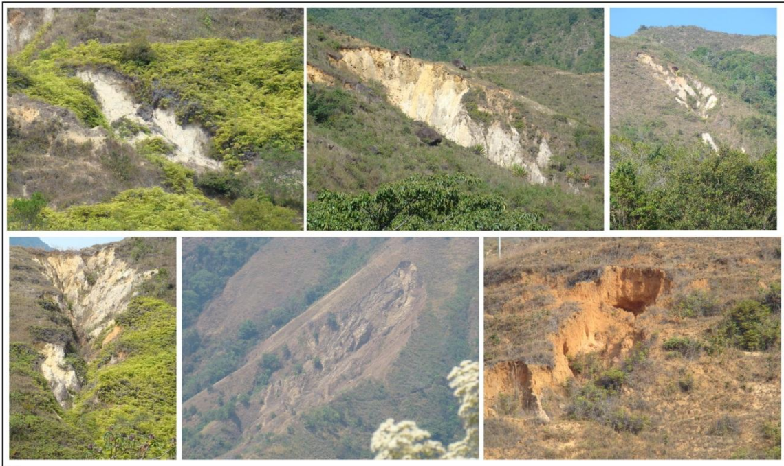
Foto 17: Panorámicas de cárcavas identificadas en el cuadrángulo de estudio.
