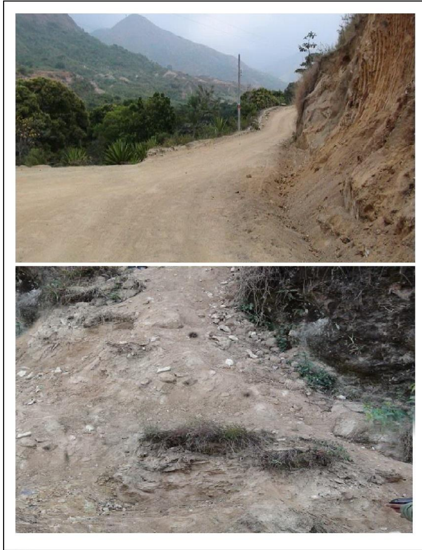
Foto 24: Zona de extracción de la muestra 2
