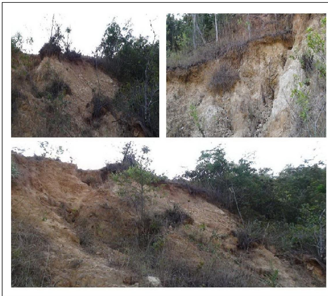
Foto 26: Zona de extracción de la muestra 4
