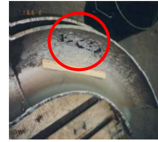
I. Corrosión por ácido nafténico. (American Petroleum Institute, 2011).
