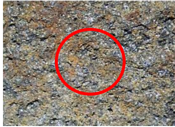
L. Corrosión por ácido sulfúrico (Padilla & Guzmán, 2019)
