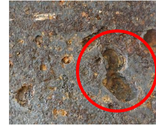
N. Corrosión microbiológicamente inducida (MIC).
