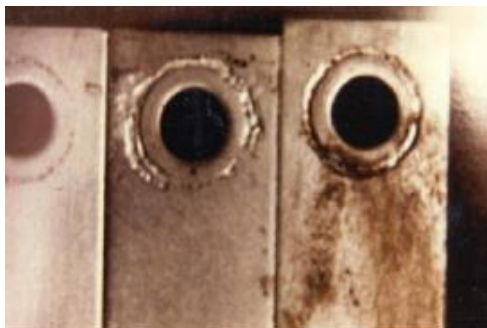
FIGURA 7. Corrosión por ranura
