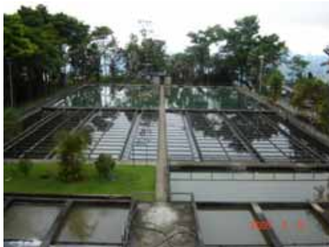
Figura 4. Sedimentadores de la planta la flora
