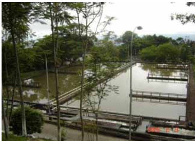
Figura 1. Presedimentadores de la planta la flora.
