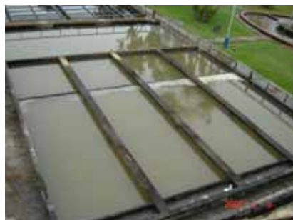
Figura 3. Floculador No 1. Planta la flora
