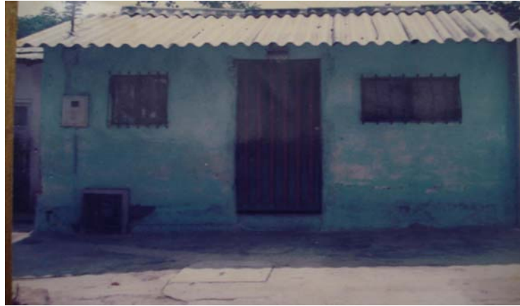
Fotografía 3. Imagen de una vivienda del barrio Nacional la Isla antes de la inundación en febrero de 2005.
