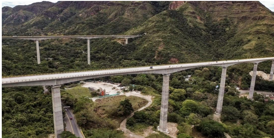
Figura 39. Viaducto Gualanday II (Sociedad Colombiana de Ingenieros, 2019).
