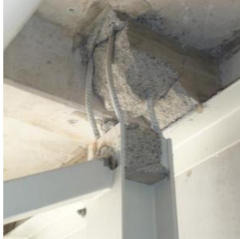
Figura 12. Poco detalle en la conexión de la columna (Clifton, Bruneau, Macrae, Leon, & Fussell, 2011).
