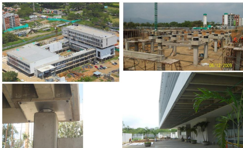
Figura 42. Clínica Comfandi, primer edificio aislado en Colombia (Oviedo, 2015).
