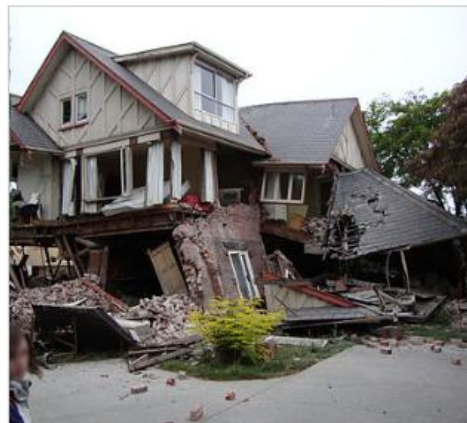
Figura 13. El edificio Pico Wholefood fue seriamente afectado por el sismo (Wikinews, 2011).
