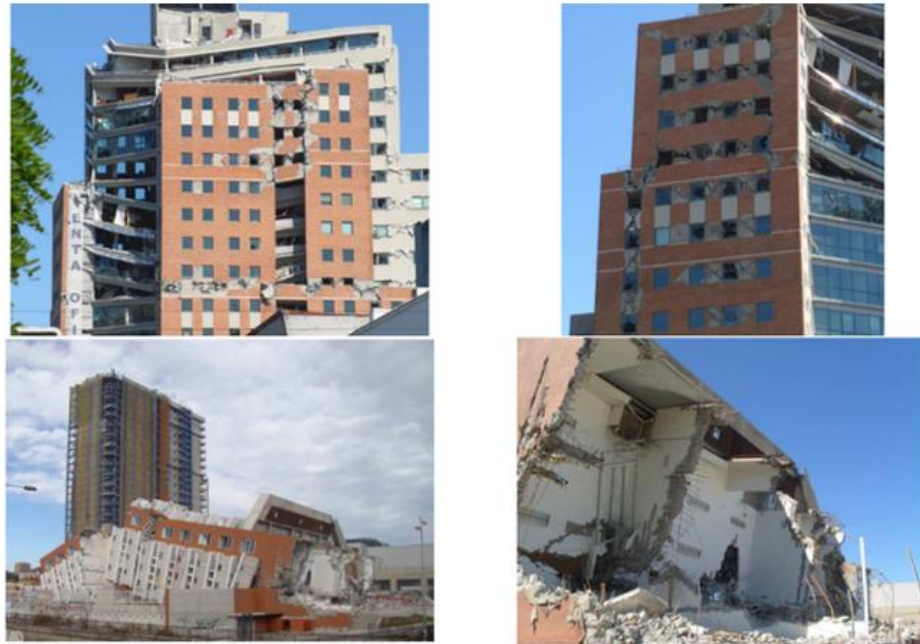
Figura 5. Edificios de muros de carga colapsados durante el sismo del 27 de febrero (Almazán, 2010).
