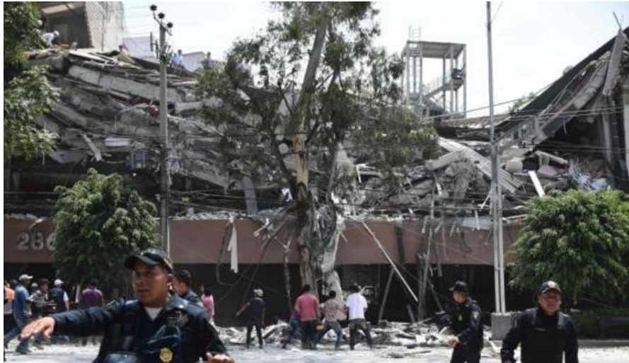
Figura 11. Colapso de edificio, el más grave que se haya visto desde el sismo de 1985 (BBC, 2017).
