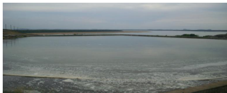
Figura 13. Tanque de Almacenamiento de Agua Potable
