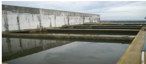
Figura 16 Sistema de Filtración en Plena Operación (Filtros Rápidos y lentos
