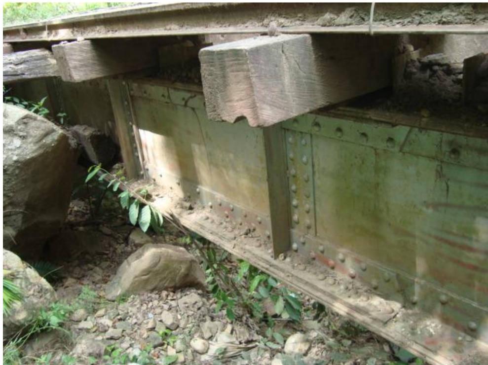
Figura 14. Vista lateral viga principal puente Sandra
