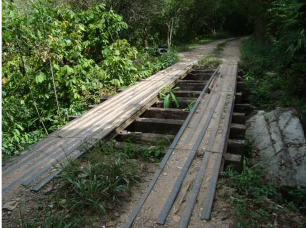
Figura 13. Tablero en huellas puente Sandra
