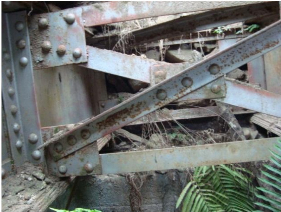
Figura 27. Arriostramiento puente Sandra
