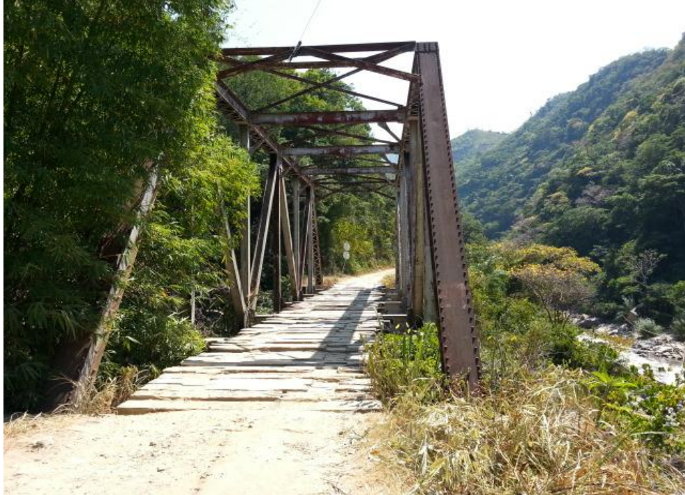
Figura 19. Tablero puente La Honda
