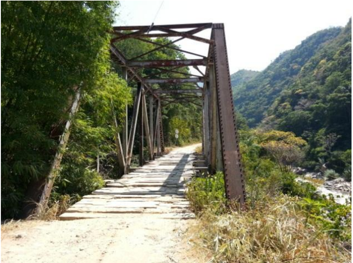
Figura 38. Vista puente La Honda
