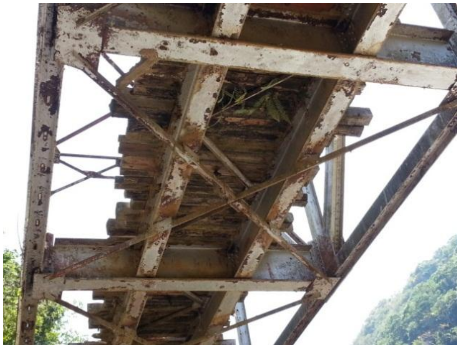
Figura 23. Arriostramiento y vigas centrales puente La Honda
