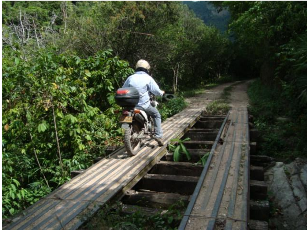
Figura 26. Paso por puente Sandra
