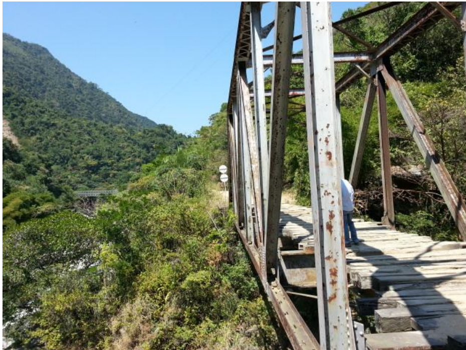
Figura 22. Cercha principal puente La Honda
