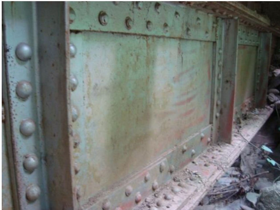
Figura 28. Viga principal puente Sandra
