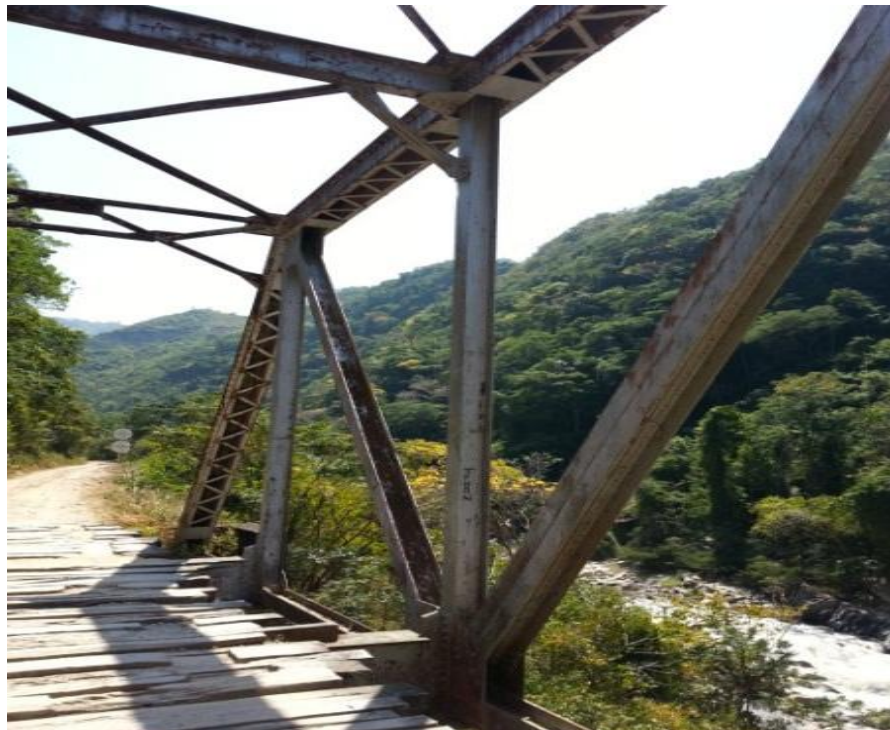
Figura 21. Celosía puente La Honda
