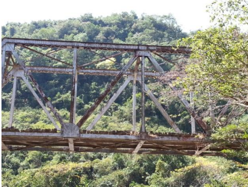
Figura 39. Cercha principal puente La Honda
