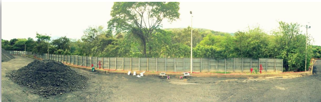
Figura 6. Barreras artificiales y naturales del patio de almacenamiento
