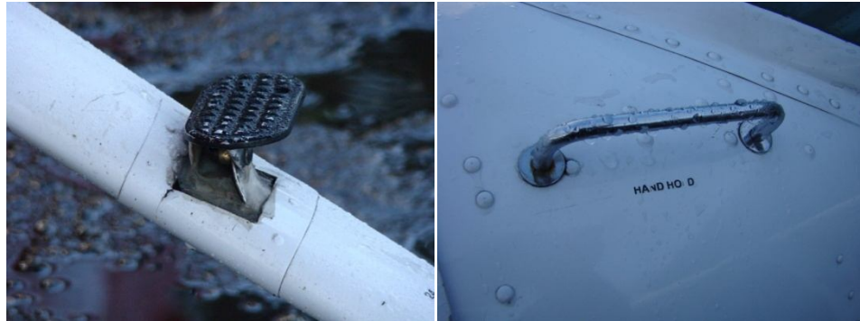
Figura 25. Peldaño y pasamanos de acceso a la cabina
