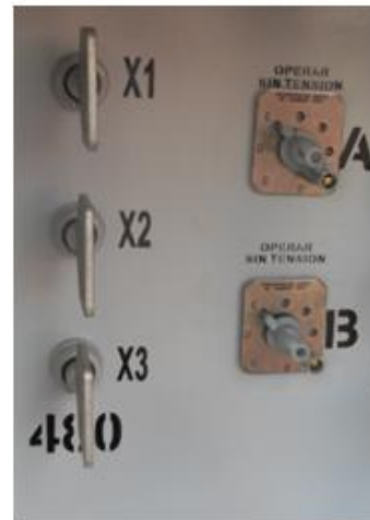
Figura 21. Variador de frecuencia (izquierda) y TAP's del transformador elevador y su configuración (derecha.)
