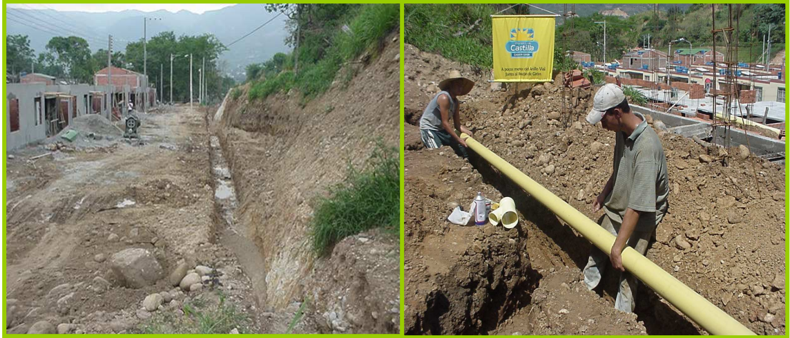
Figura 4. Excavación en roca de zanja e instalación de tubería sanitaria.
