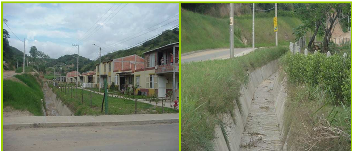
Figura 5. Canal en Concreto. Urbanización Portal de Castilla, Girón.
