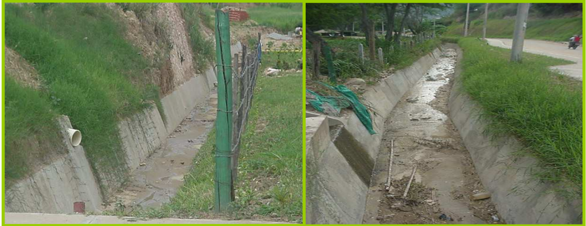
Figura 6. Entrega de Sumidero y canaleta secundaria a canal.
