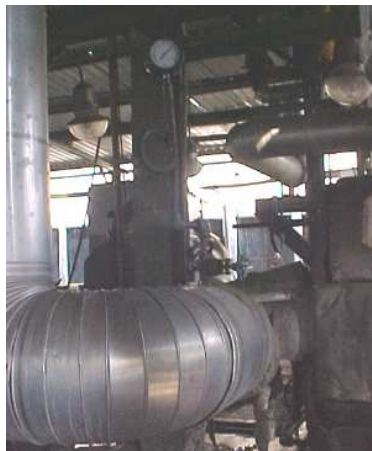
Figura 21. Medición de la presión a la entrada de la turbina
