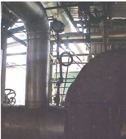
Figura 22. Medición de la presión a la salida de la turbina
