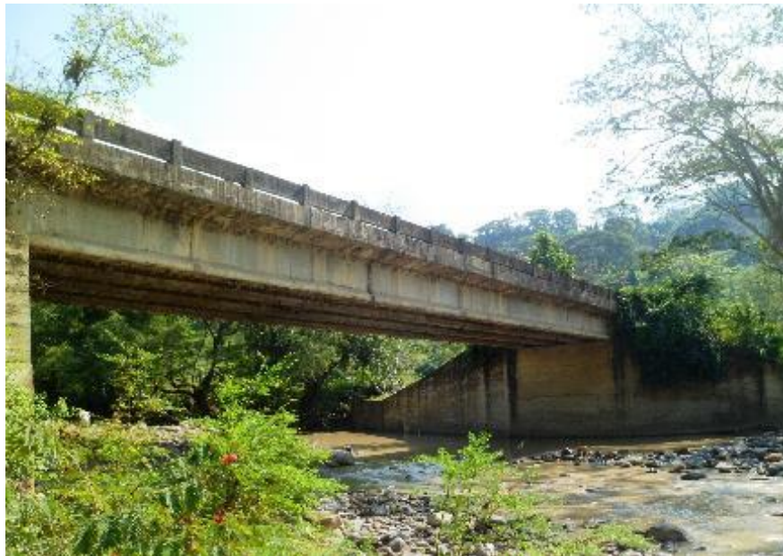
Figura 1. Vista en perfil del puente.
