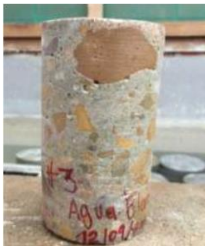
Figura 17. Núcleo de concreto puente Aguablanca.
