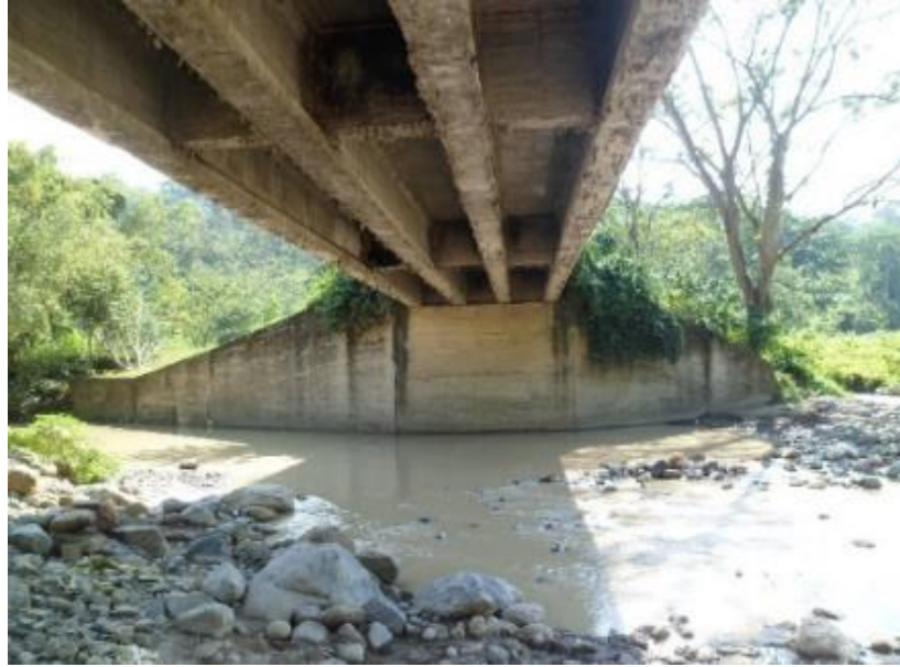
Figura 2. Vista inferior del puente.
