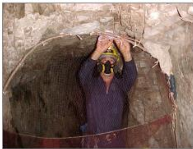
Instalación de mallas de niebla en refugio de murciélagos
