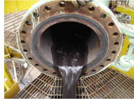
Lavado de los internos de la torre.
