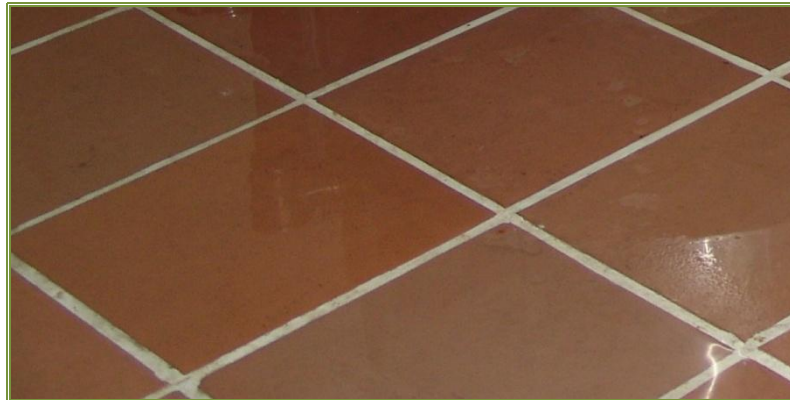
Figura 15. Piso con rendijas rellenas de sica
