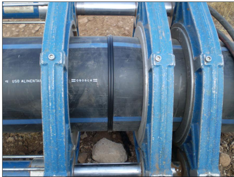
Figura 32. Detalle de la soldadura en tubos de PEAD mediante Termofusión
