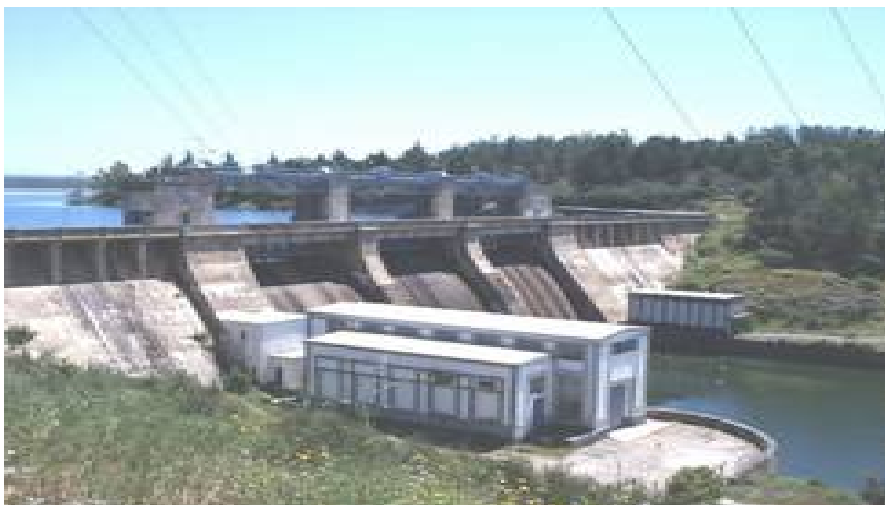
Figura 5. Presa del tipo de gravedad
