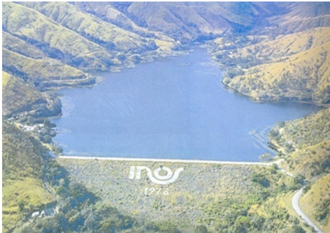
Figura 3. Presa de tierra
