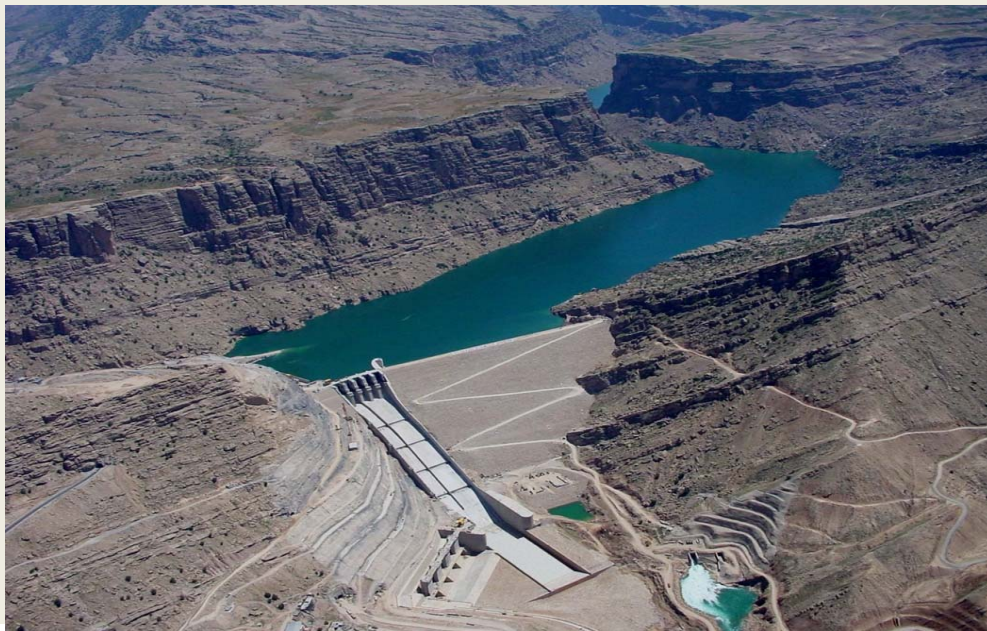
Figura 4. Presa de enrocamiento
