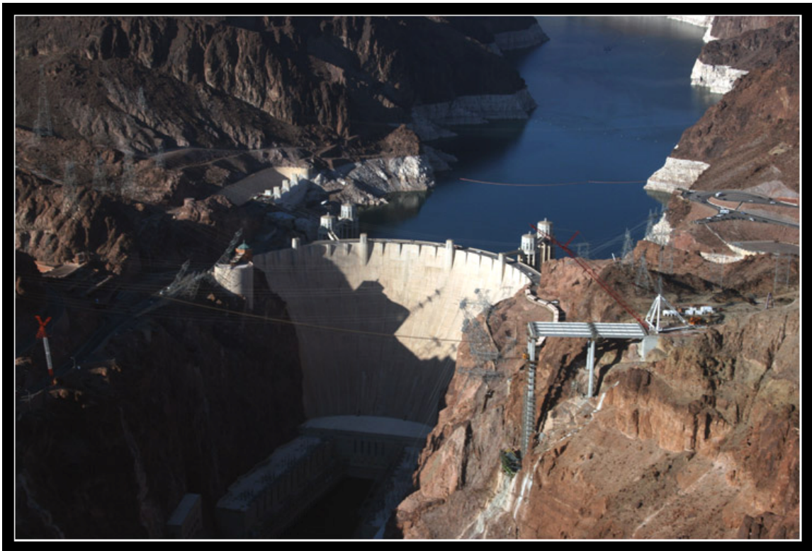
Figura 6. Presa de concreto tipo arco
