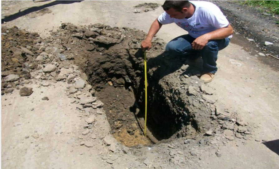
Imagen 7. Apique tomado sobre el K1+000 de la vía Gramalote – Carmen de Nazareth
