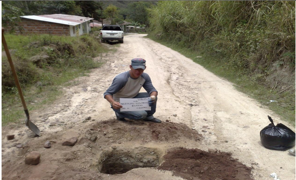
Imagen No 2. Apique No 3 K13+000
