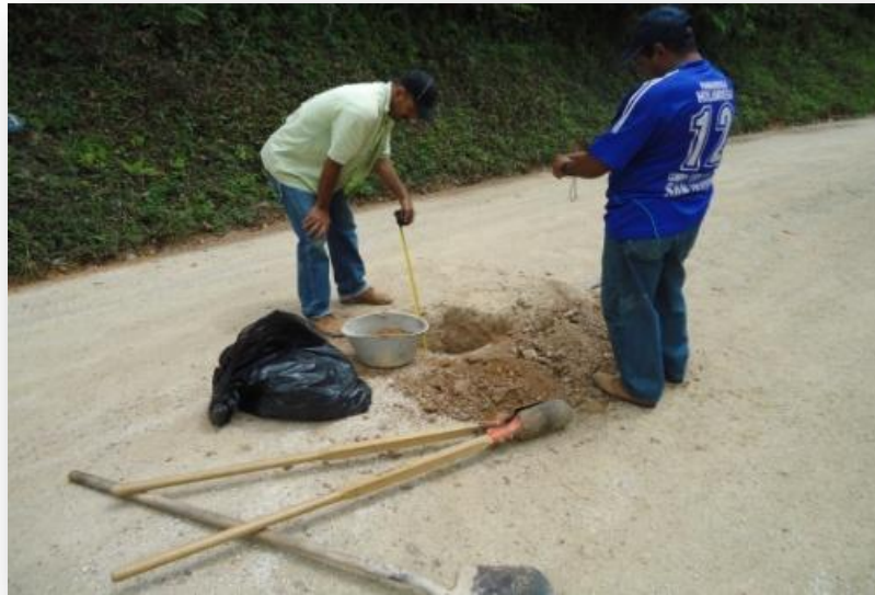
Imagen 19. Apique sobre la vía Salazar-Arboledas
