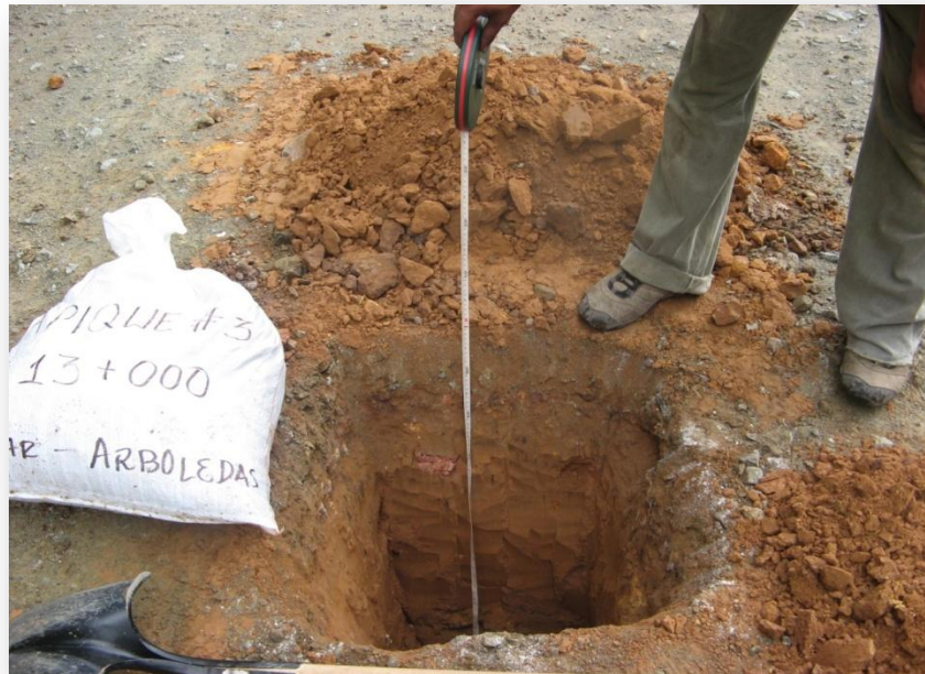
Imagen 18. Apique en la vía Salazar Arboledas sobre el K13+000.
