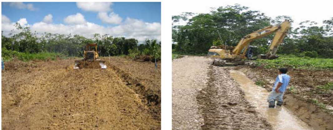
Figura No. 12 Construcción de carreteras y construcción de drenajes
