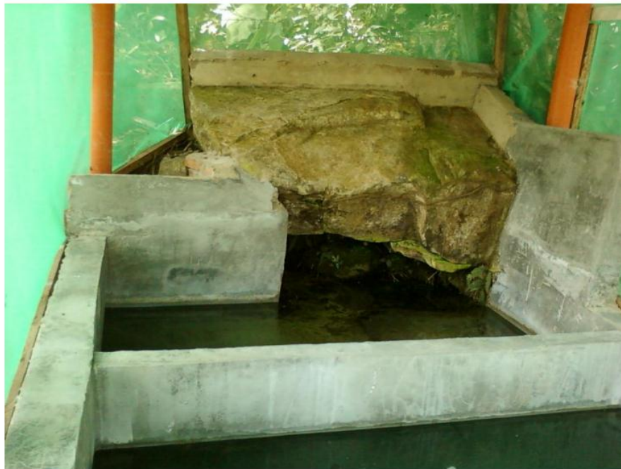
PUNTO DE NACIMIENTO Y TANQUE DE ALMACENAMIENTO DEL AGUA NATURAL
