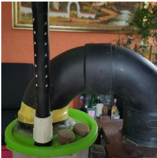
Figura 39. Detalle de instalación de los filtros.
