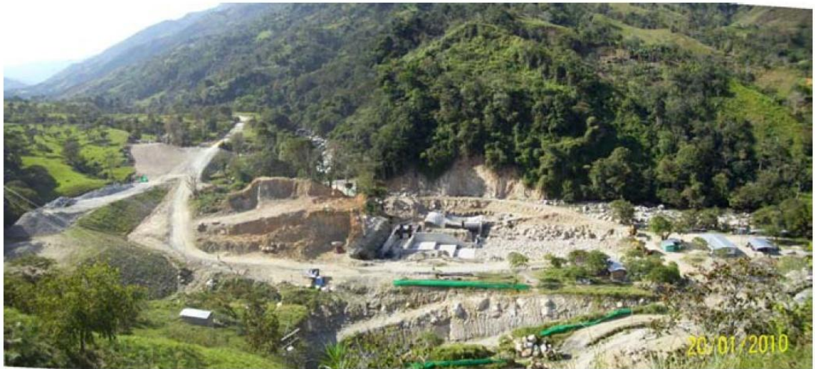
Figura 12. Construcción de Hidromontañas.
