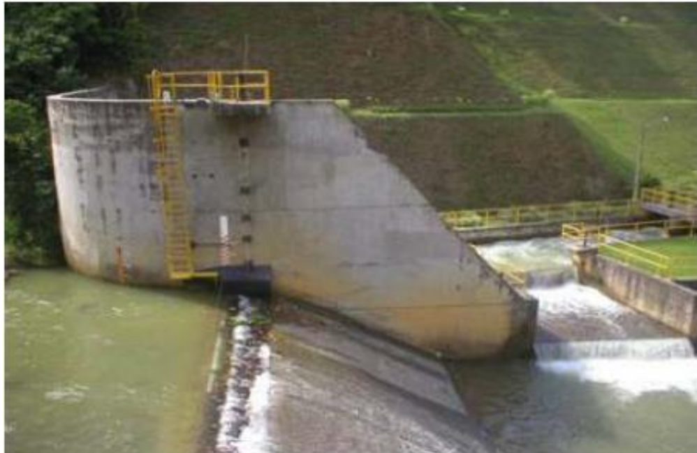
Figura 10. Obras de captación de la central Río Piedras.
