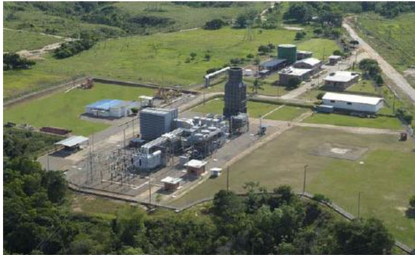
Figura 8. Vista aérea de la central Meriléctrica.
