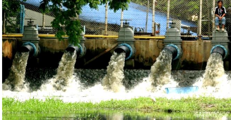
Figura 1. Vertimiento de Aguas residuales
