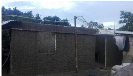
Figura 16. Alineadores de muro. Fuente: Autor
