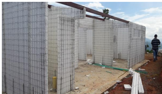
Figura 14. Instalación de perfiles. Fuente: Autor
