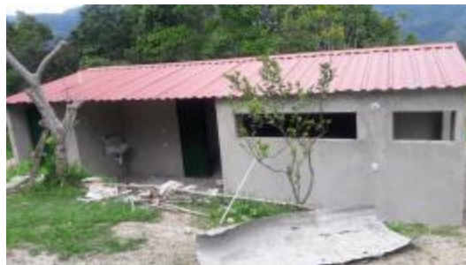
Figura 17. Cubierta termo-acústica. Fuente: Autor
