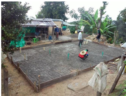
Figura 11. Solado y malla. Fuente: Autor
