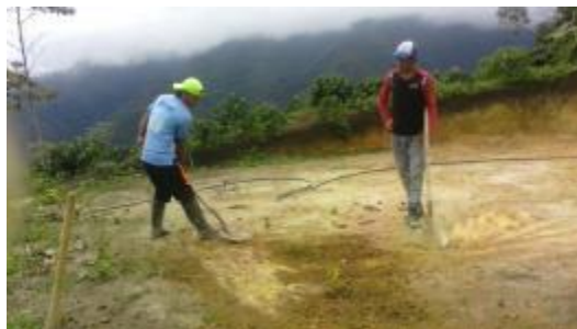
Figura 9. Trazado y replanteo. Fuente: Autor
