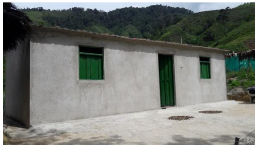
Figura 18. Carpintería metálica. Fuente: Autor
