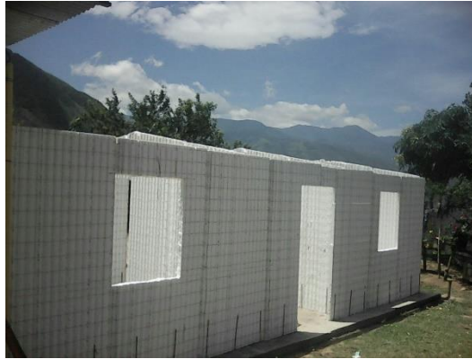
Figura 12. Vivienda en paneles. Fuente: Autor
