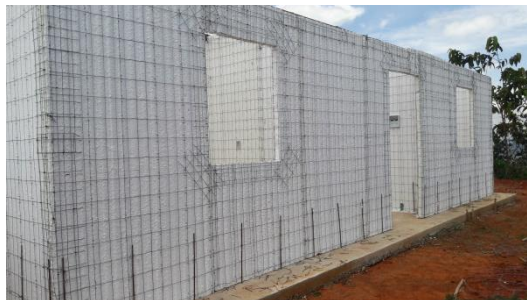
Figura 13. Mallas de refuerzo en dinteles. Fuente: Autor
