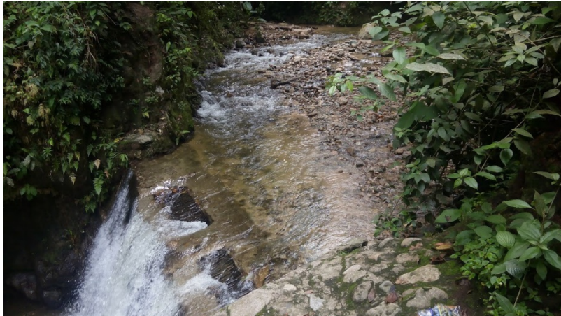
Figura 7. Bocatoma sobre la quebrada La Naranjera.
