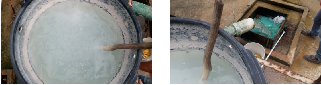
Figura 16. Proceso de desinfección con Cloro.
