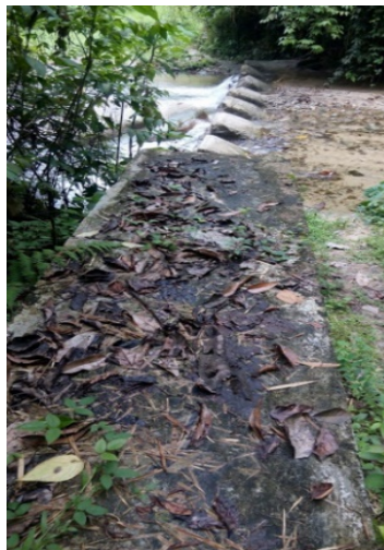
Figura 13. Estructura para Protección de tubería.
