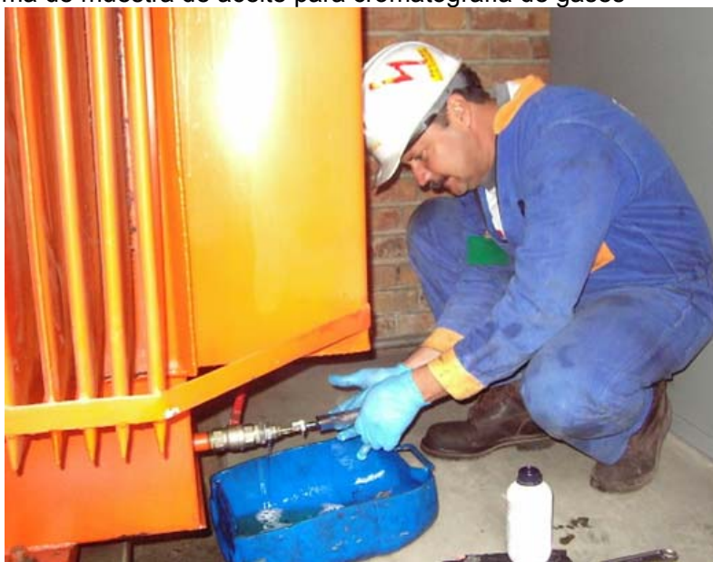
Figura 16. Toma de muestra de aceite para cromatografía de gases
