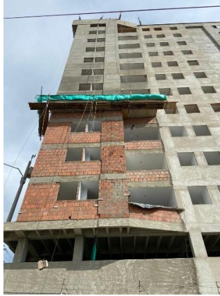
Figura 14 Friso Fachada Norte Edificio Akau25
