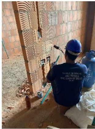
Figura 29 Prolongación Tubería Eléctrica
