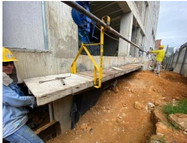
Figura 13 Andamio Fachada Externa Edificio Akau25
