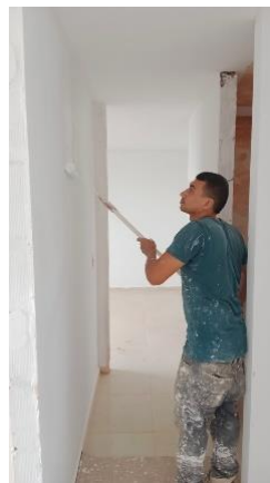
Figura 24 Pintura Apartamentos Edificio Akau25
