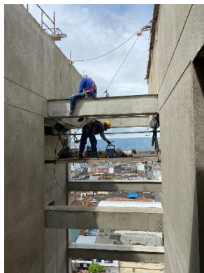
Figura 16 Alfajía en Eterboard Vigas de amarre
