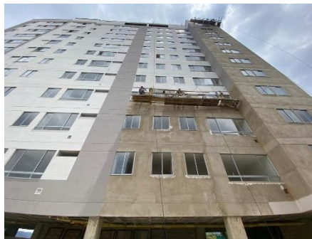
Figura 17 Fachada Sur Edificio Akau25
