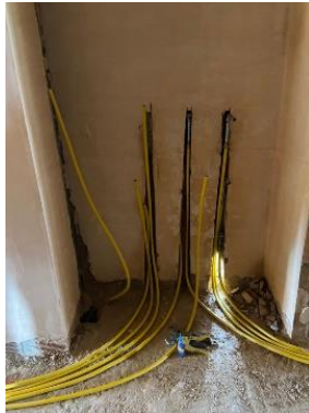
Figura 31 Instalación Tubería Gas Pasillos
