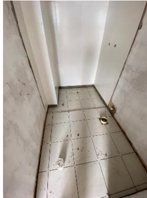
Figura 19 Enchape Piso y Pared Baños Apartamentos
