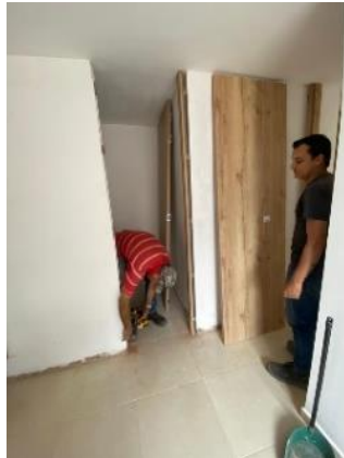
Figura 37 Instalación Puertas internas Apartamentos
