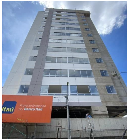
Figura 1 Fachada Frontal Edificio Akau25.
