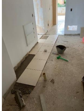
Figura 20 Enchape pasillos Edificio Akau25
