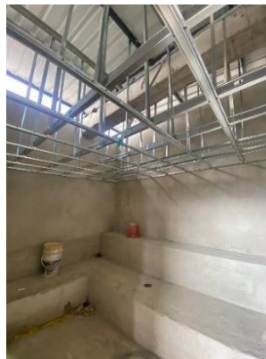
Figura 32 Instalación Cielo Raso Turco
