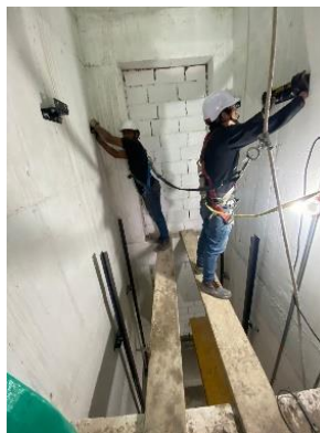
Figura 38 Instalación Ascensores Edificio Akau25
