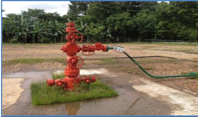
Figura 25: Cabezal de pozo Casabe CR4.
