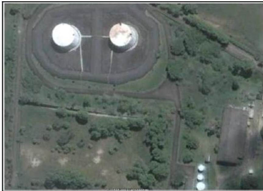
Figura 15: Estación de bombeo cóndor.
