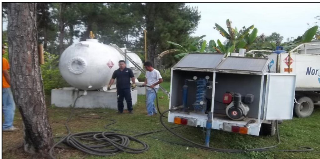
Figura 24. Tanque de gas
