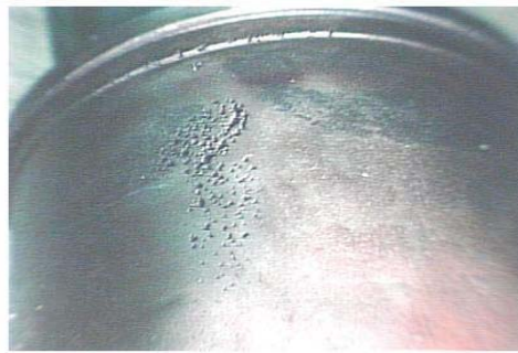
Figura 13. Corrosion por Picadura.
