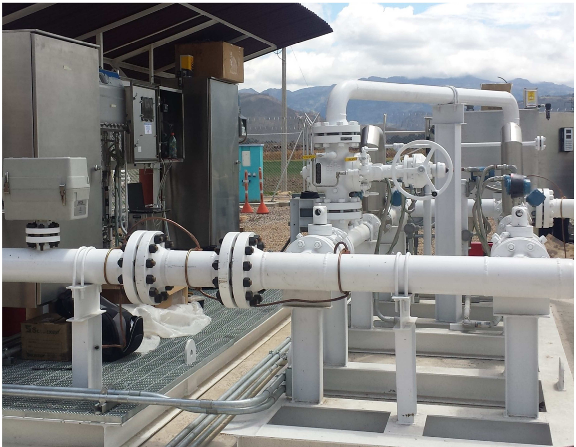
Figura 13. Sistema de medición
