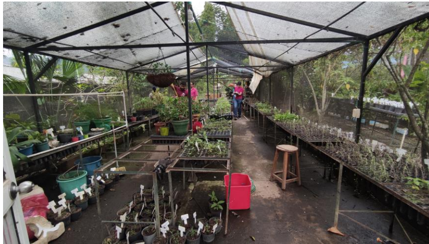
Figura A3 Estado de la infraestructura del vivero
