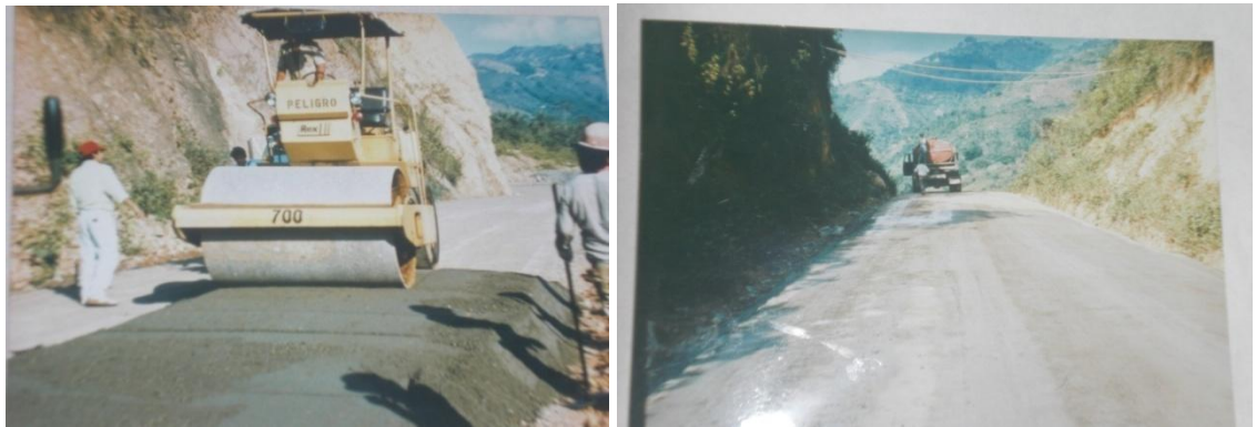
Figura 1a. Construcción tramo experimental en CCR (planta cementos diamante)
