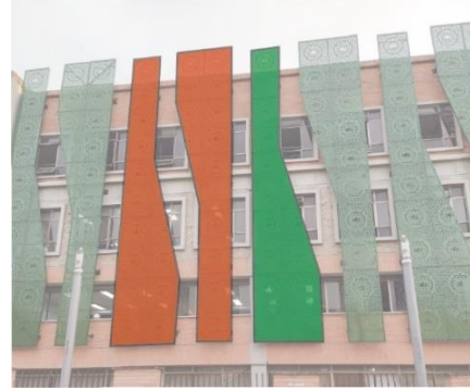
Intervención de la estructura para formas y conceptos
