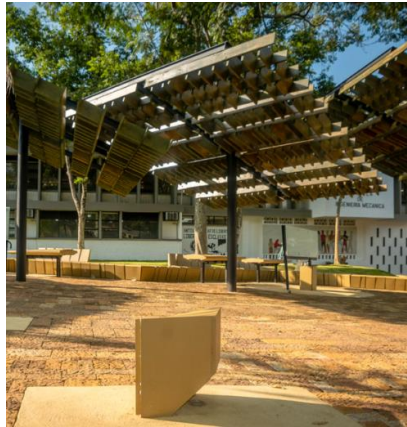
Plazoleta de mecánica. Concepto Barichara. Arteconcreto. [Recuperado el 3 enero 2021] Disponible en: https://arteconcreto.co/proyectos-recientes/proyecto-uis/
