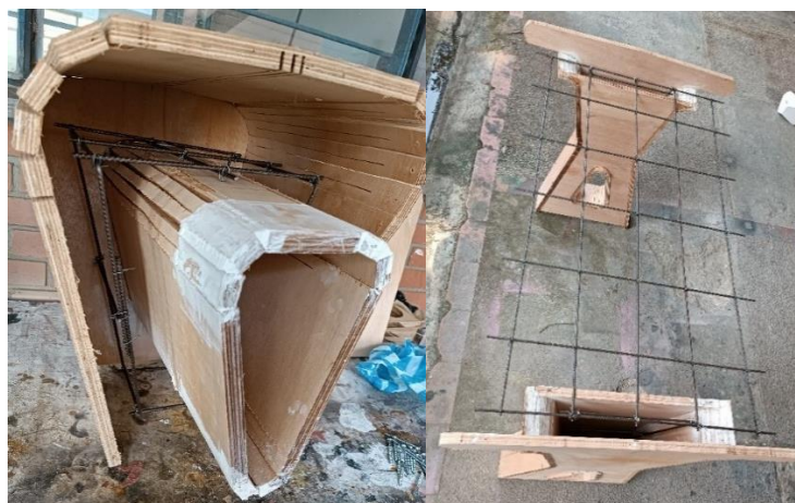
Estructura de varilla en metal. Fuente el autor.
