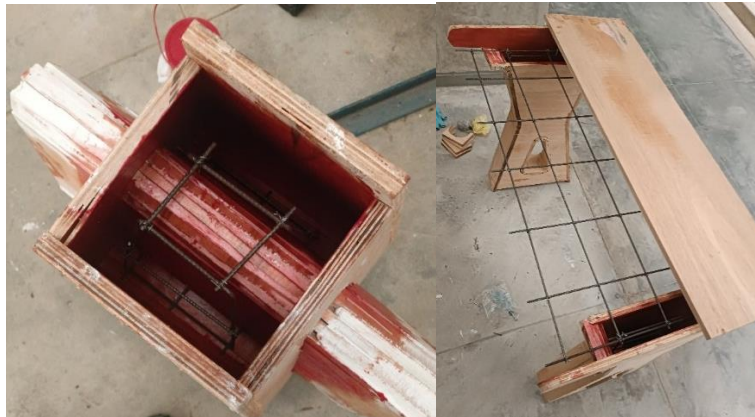
Molde con aplicación de grasa. Fuente el autor.
