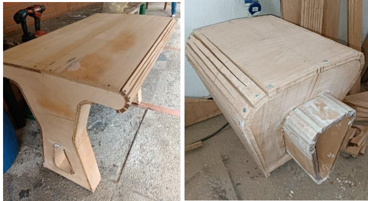
Formaletas para la mesa y banca en madera. Fuente el autor.
