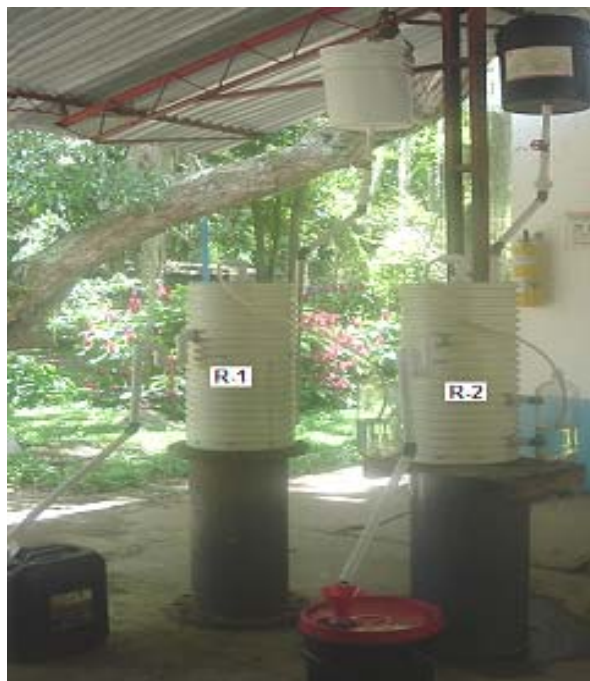
Instalación del sistema
