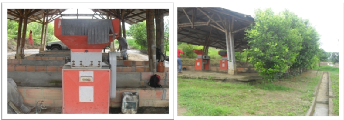
Fotografía No. 14. Vista general planta de compostaje de San Gil
