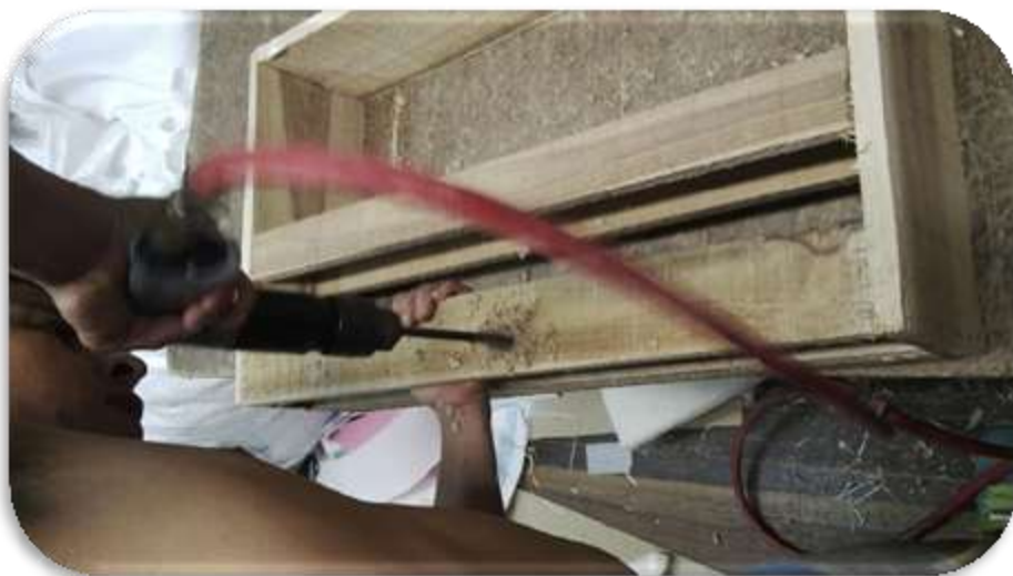
Figura 86. Orificio en laterales para tubos de acero
