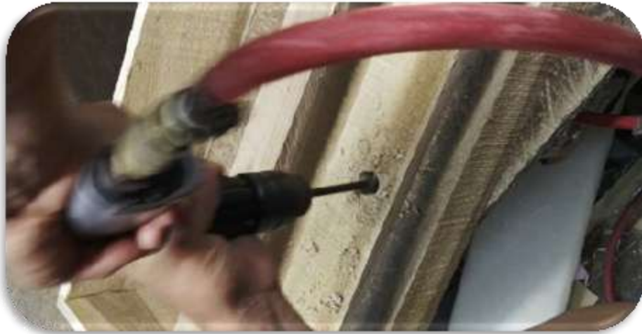
Figura 81. Abertura de huecos extensión espaldar
