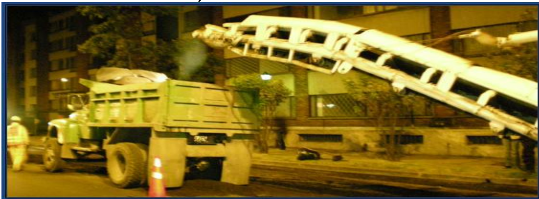
Figura 1 Fresado y cargue de escombros. (Acción captada en el frente de obra).
