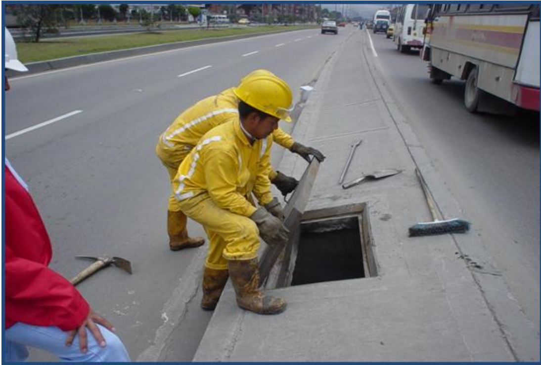
Figura 3 Limpieza de sumideros. (Fotografía tomada ejecutando acciones propias).
