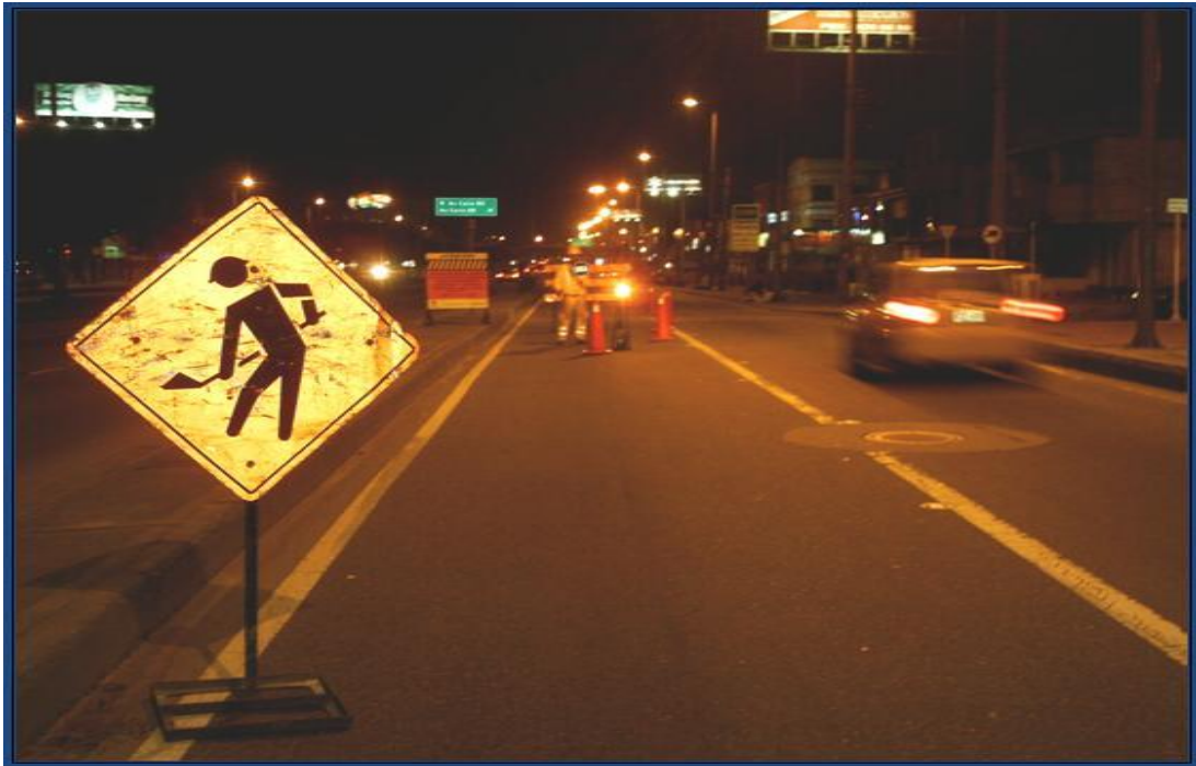
Figura 2 Señalización nocturna de aproximación, preventiva y obligatoria que indica al conductor que hay obras en la vía.
