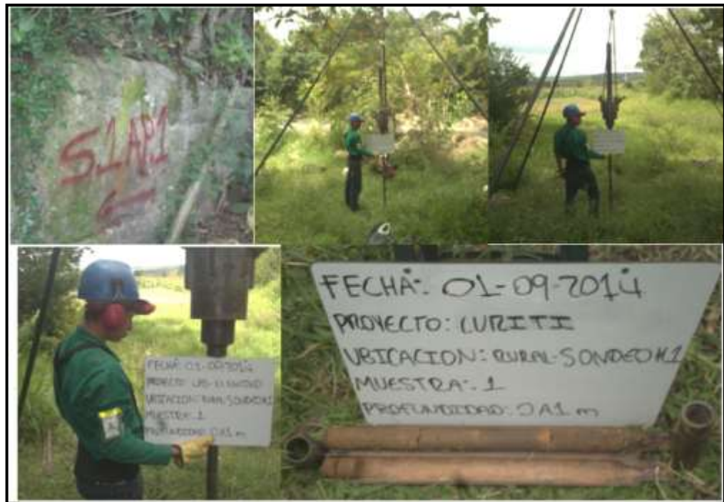
Figura 52. Registro fotográfico sondeo 1
