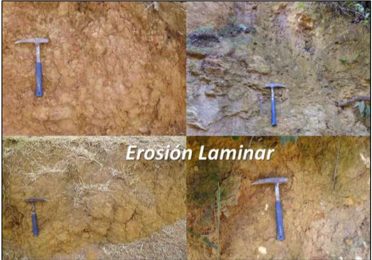
Figura 28. Erosión Laminar en el casco urbano del Municipio de Curití
