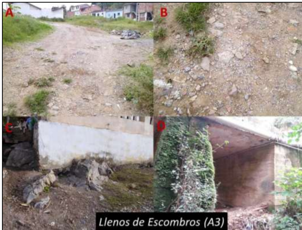
Figura 25. Llenos de Escombros en el casco urbano del Municipio de Curití.
