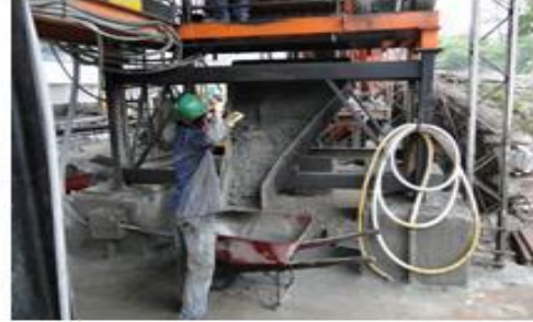
FIGURA 36 Llenado de las formaletas con la materia prima. Fuente: Autor del proyecto
