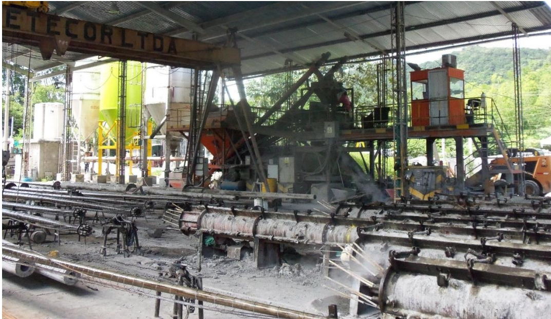
FIGURA 15 Planta mezcladora Altron AM-25 de PRETECOR LTDA. Fuente: Autor del proyecto.
