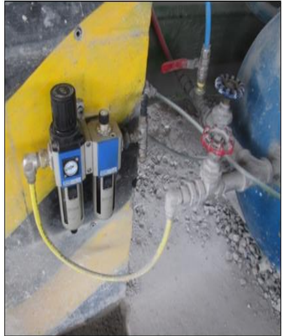
FIGURA 18 Compresor y su unidad de mantenimiento. Fuente: Autor de proyecto
