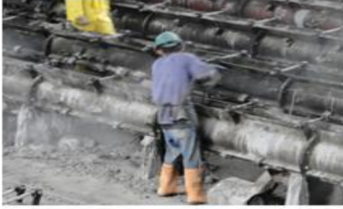
FIGURA 36 Llenado de las formaletas con la materia prima. Fuente: Autor del proyecto
