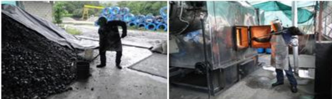
FIGURA 37 Caldera para la producción de vapor. Fuente: Autor del proyecto
