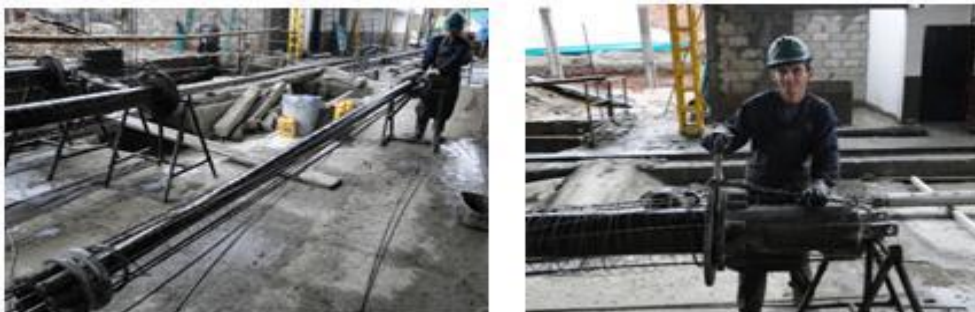
FIGURA 34 Refuerzo de Acero. Fuente: Autor del proyecto
