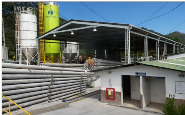
FIGURA 3. Instalaciones PRETECOR Ltda. Fuente: Autor del proyecto.
