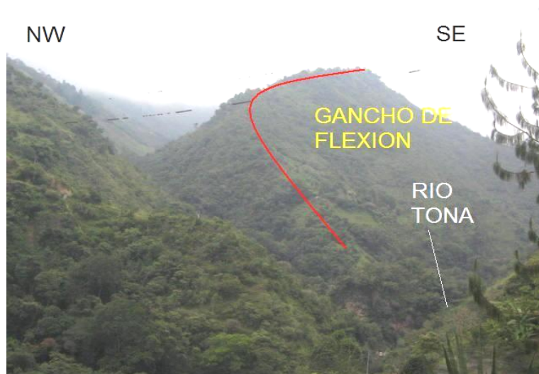
Figura 21. Gancho de flexión, producto de la Falla Río Fío y lineamientos en dirección NE y SW, a un costado del río Tona en la vía que conduce a Árbol Solo
