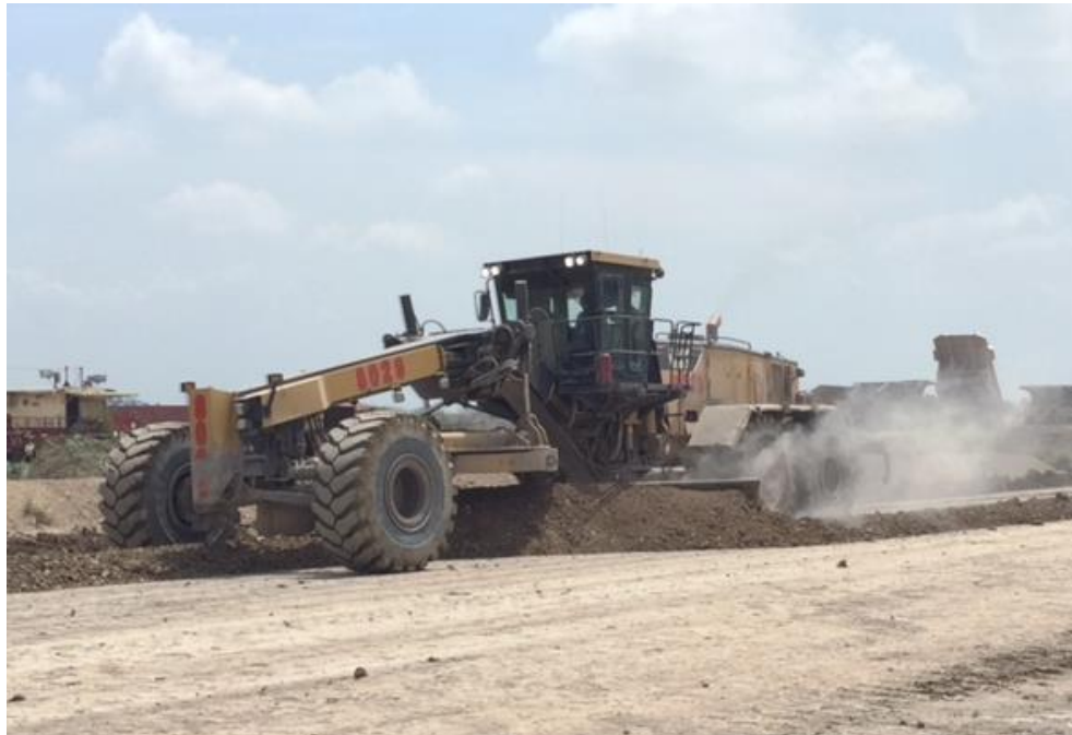
Figura 11. Motoniveladora CAT 24M en arreglo de vías, mina El Descanso. Drummond Ltd.
