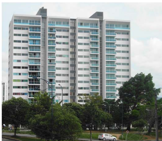
Torre Picasso: Ubicación: Calle 105 Carrera 26ª provenza – Bucaramnaga – Santander. Cliente: HG Constructora S.A.
