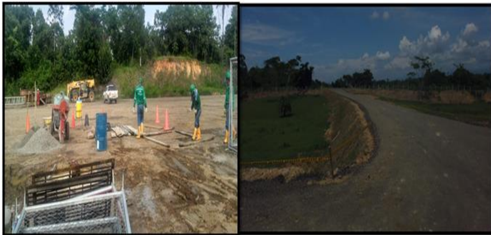
Figura 7. Trabajadores de obras civiles adecuando el terreno
