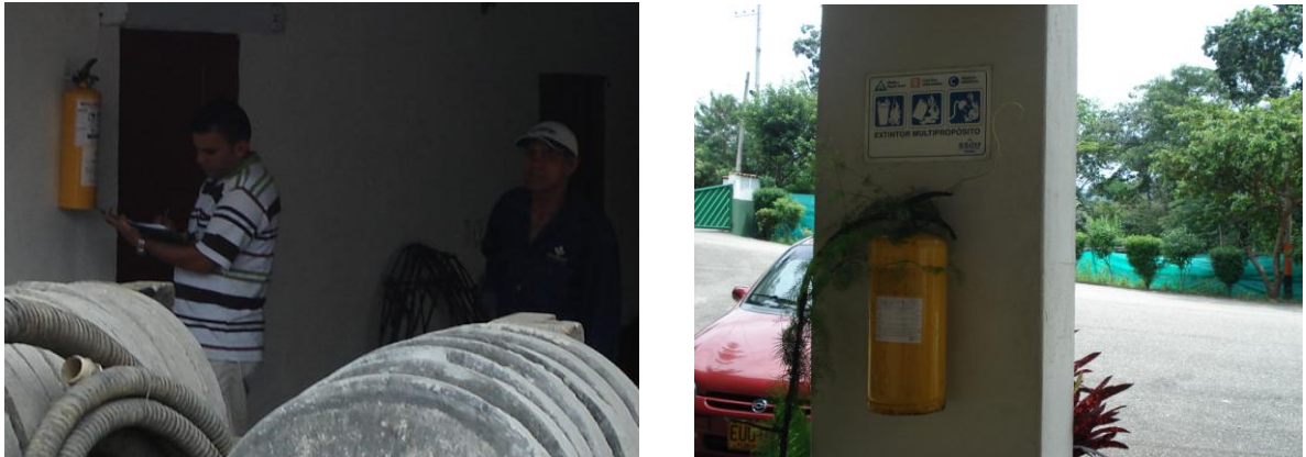
Foto 21. Inspección de extintores.
