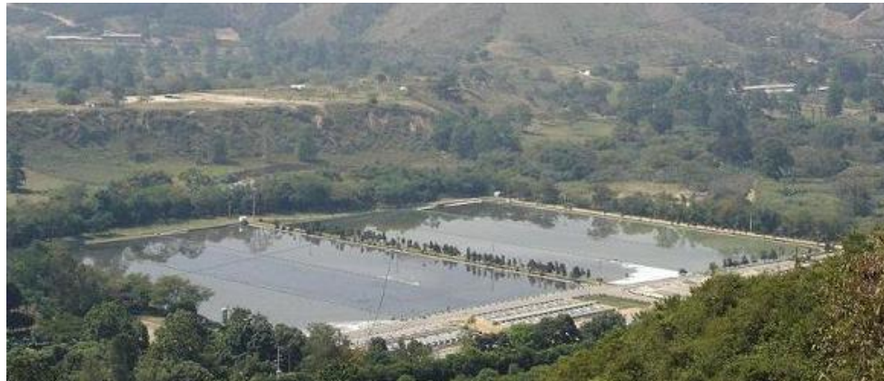
Foto 2. Planta de aguas residuales.
