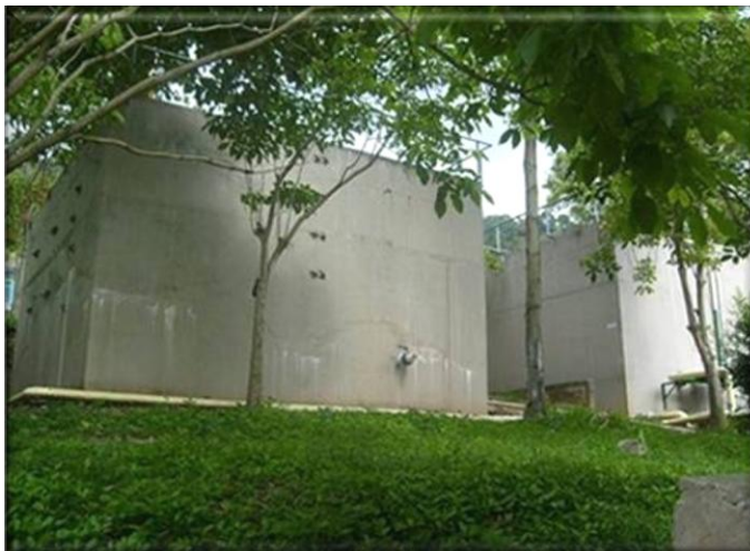
Foto 4. Tanques de almacenamiento de aguas residuales
