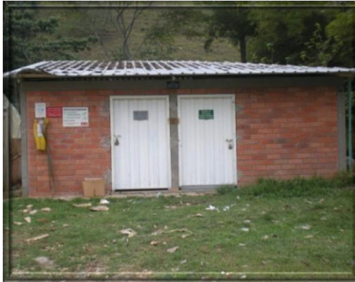
Foto 14. Cuartos de residuos sólidos y reciclables
