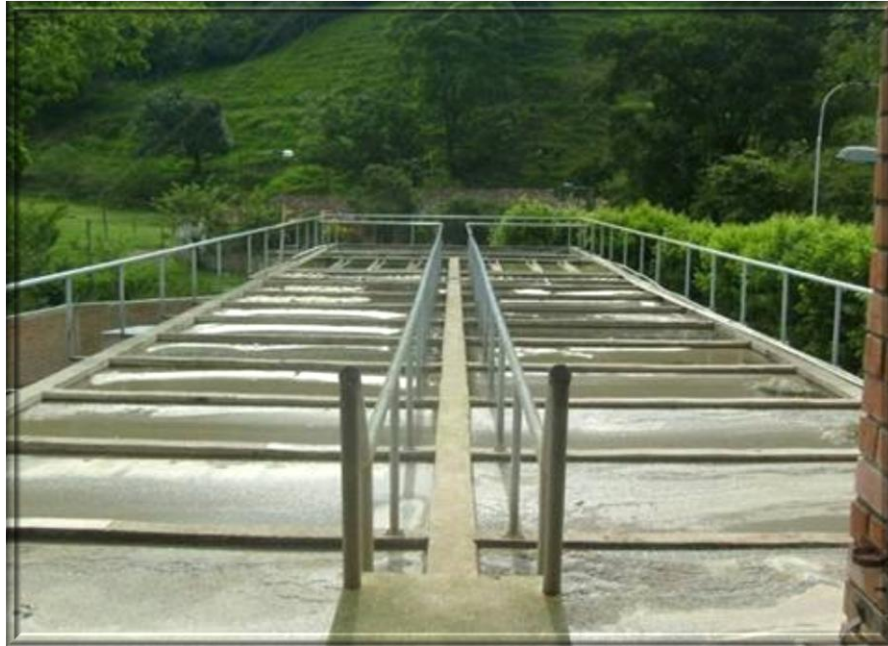
Foto 6. Planta de agua residual
