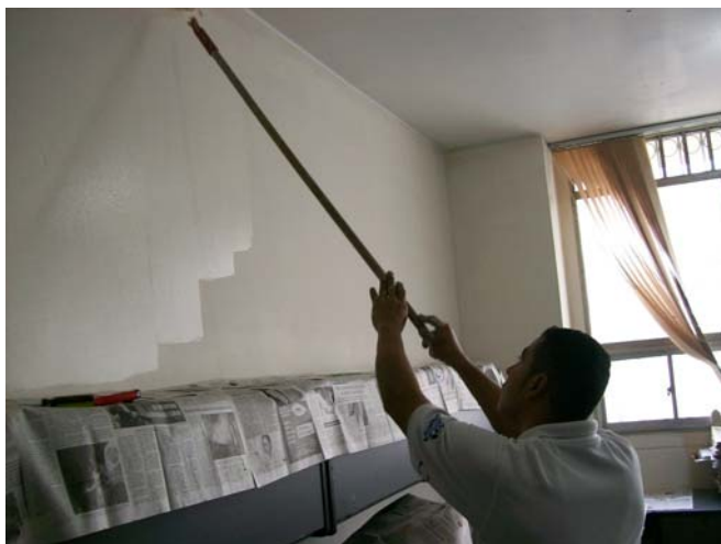
Foto 8 Mantenimiento de Fachada y Oficinas Administrativas.
