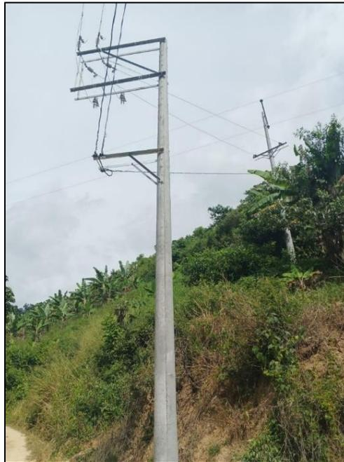
En este caso las distancias que deben tener entre las líneas de media y de baja tensión debe ser de 0,456 m según lo estipulado en el RETIE en la tabla 13.5, Adicionalmente se solicitó la instalación de crucetas para la red de baja tensión presente en la Figura 15 debido a que al pasar la línea a los puntos adicionales del circuito se presentaba podía presentar un cruce con la vegetación presente en el lugar.
