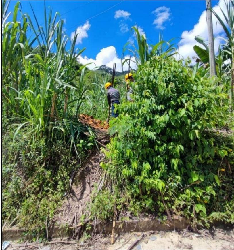
Luego se llevó a cabo el proceso de hincado de postes en el cual con ayuda de la grúa se posicionan los apoyos en el lugar designado, para este tipo de procesos es necesario tener todos los elementos de seguridad y además de eso cumplir con los protocolos para trabajar con este tipo de maquinaria, cuando se tienen los apoyos hincados se estabilizan con algunos materiales presentes en terreno a la espera de las actividades de cimentación.
